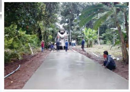
๒. โครงการก่อสร้างถนน คสล. หมู่ที่ ๖ ซอยบ้านนายพลอย สุทธะตั้ง
