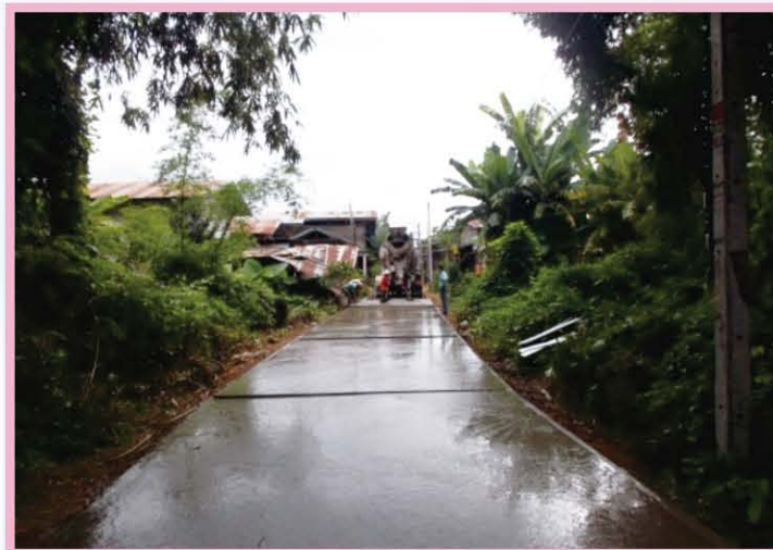
๓. โครงการก่อสร้างถนน คสล. หมู่ที่ ๔ ซอยดาวเรือง ตอนปลาย
