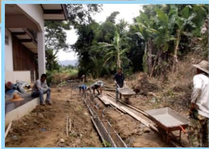
๑. โครงการก่อสร้างรางระบายน้ำ คสล. หมู่ที่ ๔ บ้านร่องยาง (ซอยดอกแก้ว และซอยพกามาศ)
